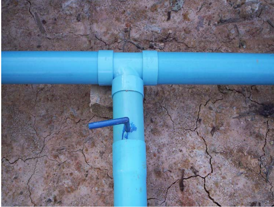
ภาพที่ 9.9 ภาพแสดงวาล์วปิดเปิดควบคุมการเติมอากาศแบบทำเอง
