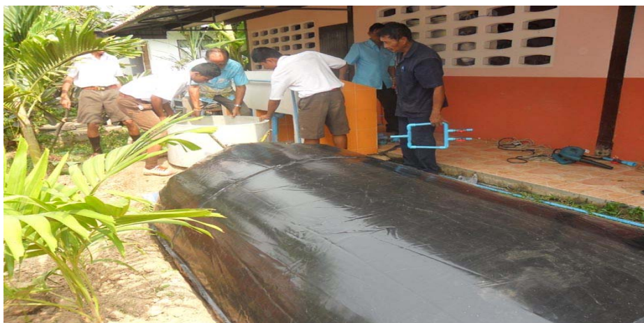
ภาพที่ 9.10 แสดงถังหมักก๊าซชีวภาพแบบถุงหมักพลาสติก
