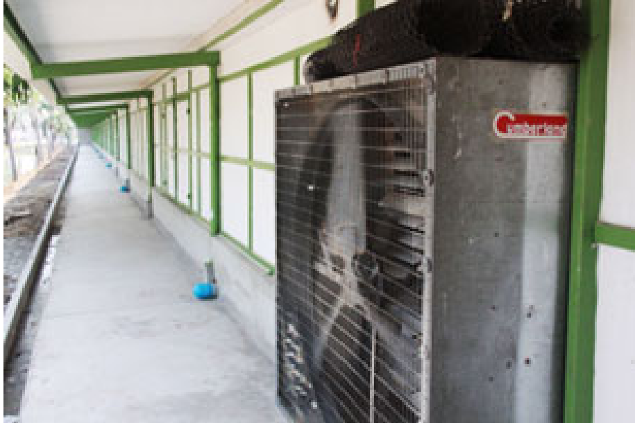
ภาพที่ 4.141 ด้านข้างโรงเรือนไก่ผนังไฟเบอร์ซีเมนต์
