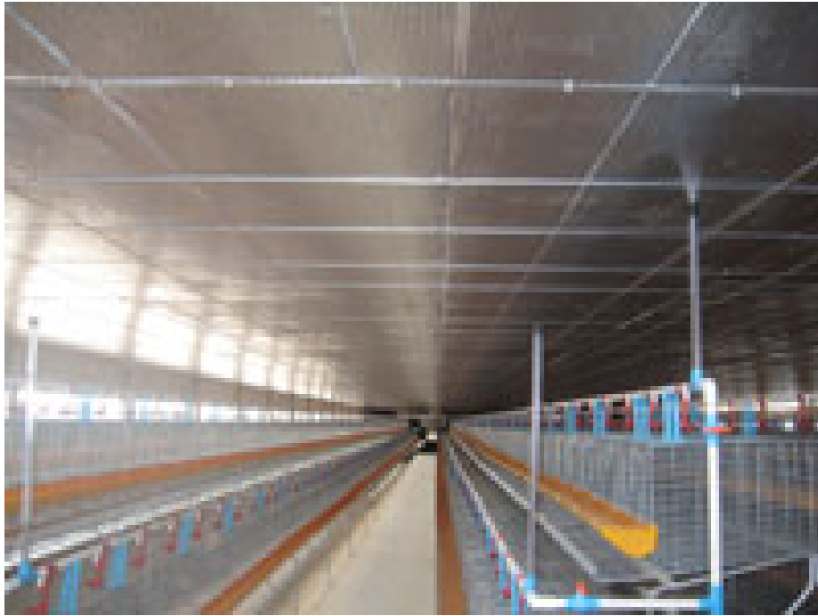
ภาพที่ 4.134 พลาสติก Polynum Reflective Insulation ใต้หลังคาโรงเรือน
