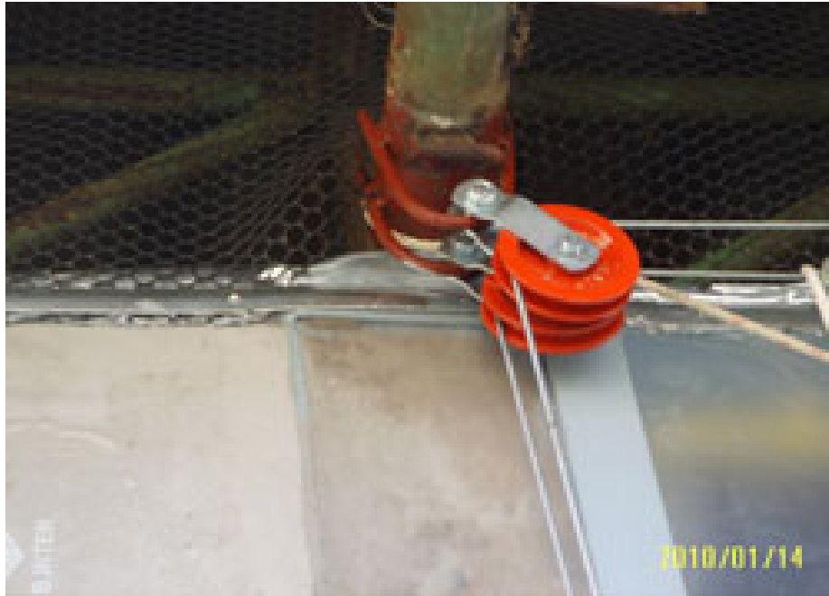
ภาพที่ 4.143 ด้านข้างโรงเรือนติดตั้งรอกกว้านแผ่นพลาสติก
