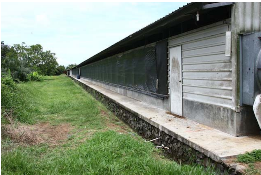
ภาพที่ 4.140 ด้านข้างโรงเรือนไก่พันธุ์ซีเมนต์ครึ่งเดียว หุ้มทับด้วยพลาสติก
