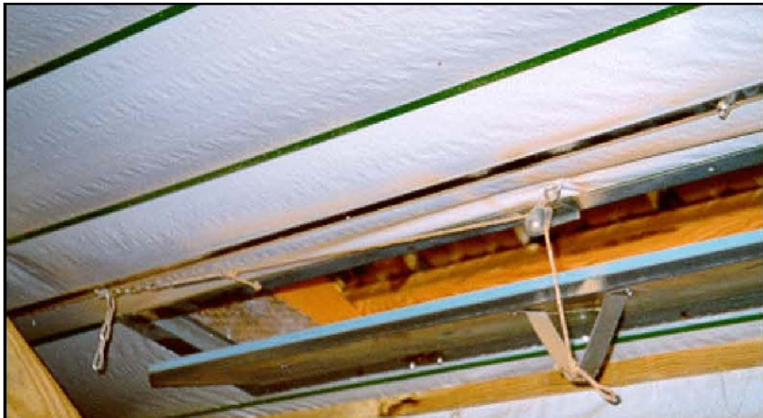
ภาพที่ 4.133 พลาสติกไวไนลใต้หลังคาโรงเรือน
