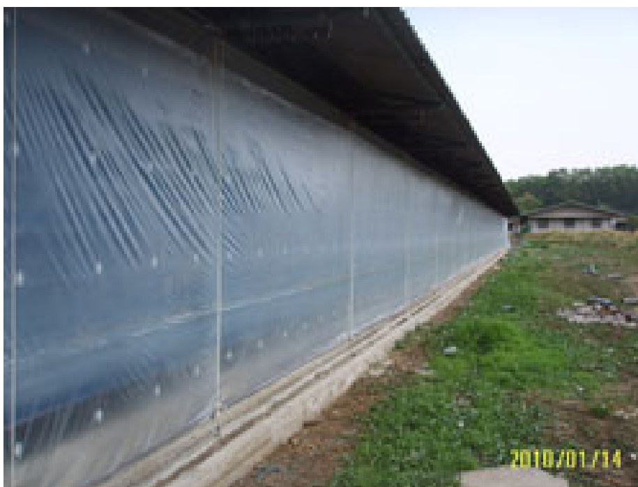
ภาพที่ 4.138 ด้านข้างโรงเรือนสุกรผนังซีเมนต์ครึ่งเดียว คุ้มทับด้วยพลาสติก
