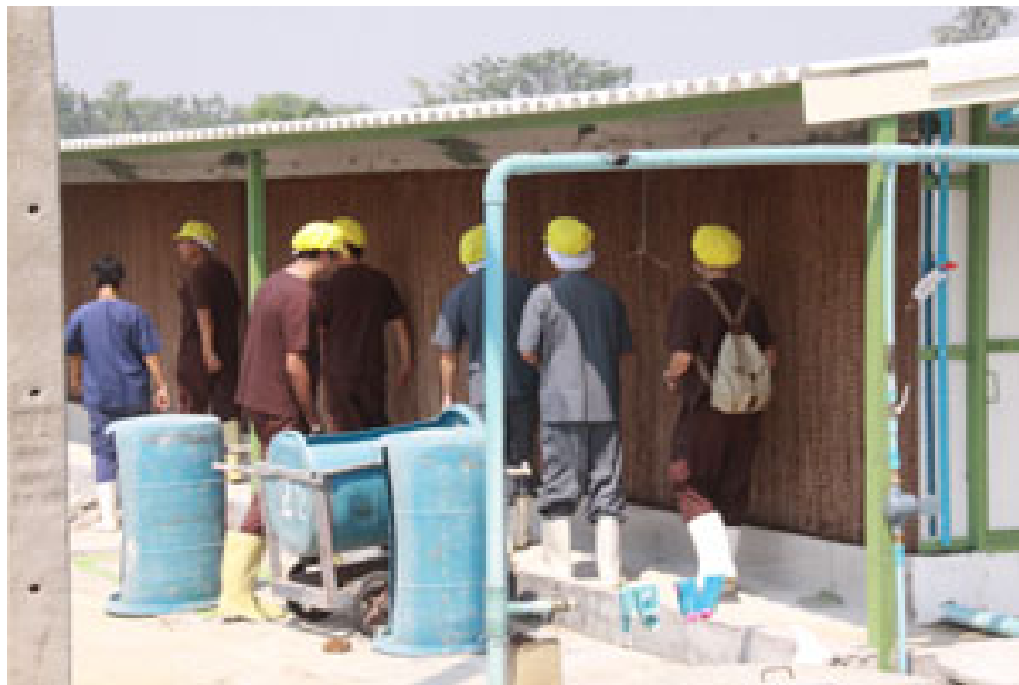
ภาพที่ 4.145 การติดตั้งแผ่นรังผึ้งในโรงเรือนไก่
